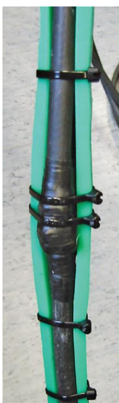
Fot. 1.2.9.4. Jako wzmocnienie połączeń służą plastikowe łubki, do których wiązadłami są przywiązane końce kabli
